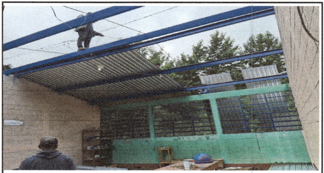
Foto 4: trabajos de mantenimiento a costaneras y cambio de techo del módulo 2
