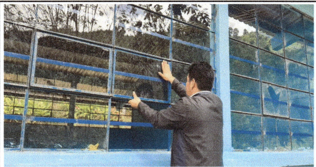
Foto 5: Instalación de vidrios nuevos módulo 2
