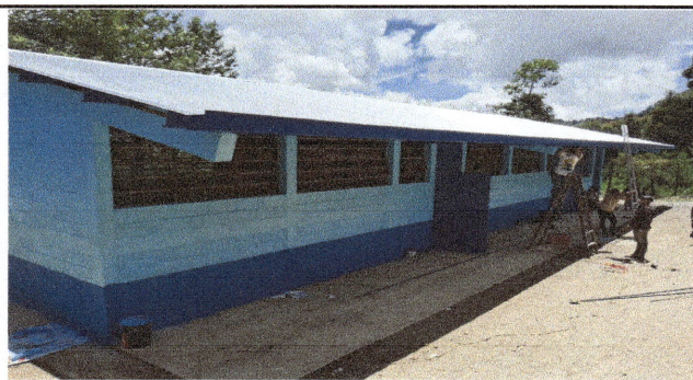
Foto 9: instalación de canal pluvial módulo 1
