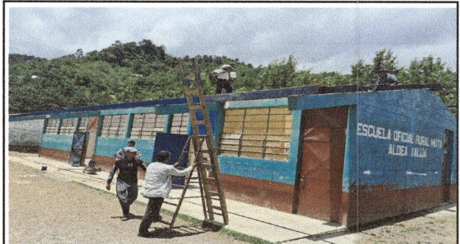
Foto2: trabajos de mantenimiento a costaneras y sustitucion de techo del módulo 1
