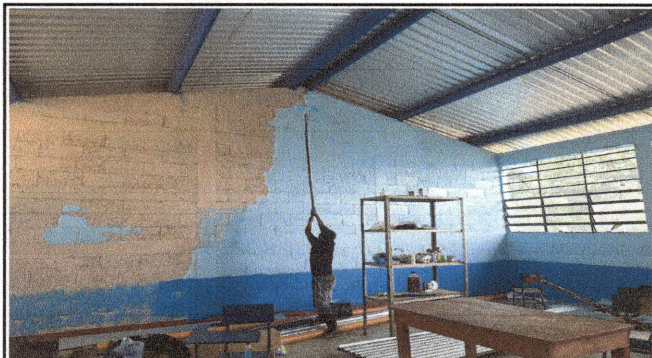
Foto 7: trabajos de pintura en aula del módulo 1
